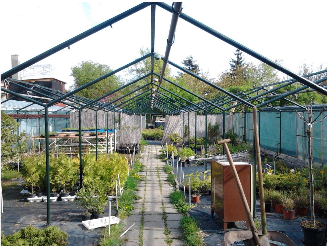
TRUBKOVÁ SVAŘOVANÁ RÁMOVÁ KONSTRUKCE NA BETONOVÉ POSADĚ BEZ VÝPLNÍ STŘEDEM SKLENÍKU VEDE CHODNÍK SESKLÁDANÝ Z BETONOVÝCH DLAŽDIC VOLNĚ POLOŽENÝCH NA TERÉN. PODÉLNĚ SKLENÍKEM ZAVĚŠENA 3 X TRUBKA ZAVLAŽOVACÍHO ZAŘÍZENÍ
